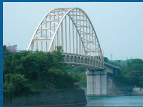
2号橋 (大矢野橋)
